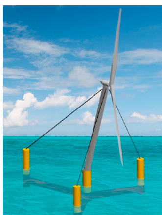
図 1.15: NEDO による一点係留式浮体式風車
